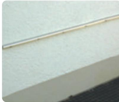
Wandleiste mit passenden Dübeln und Schrauben befestigen und Wandseitig mit Silikon abdichten!
