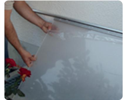
Abdeckung mit Doppel-Kederband in die Wandleiste einziehen.
