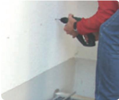
Löcher für Wandleiste bohren – mit Wasserwaage kontrollieren!
