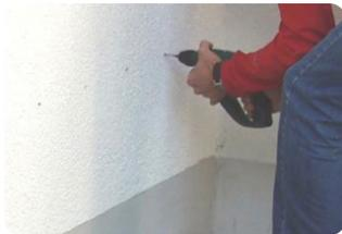
Wandleiste mit passenden Dübeln und Schrauben befestigen.
